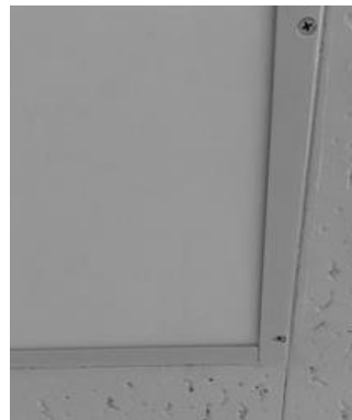
隙間をコーキング剤で埋めた状態
