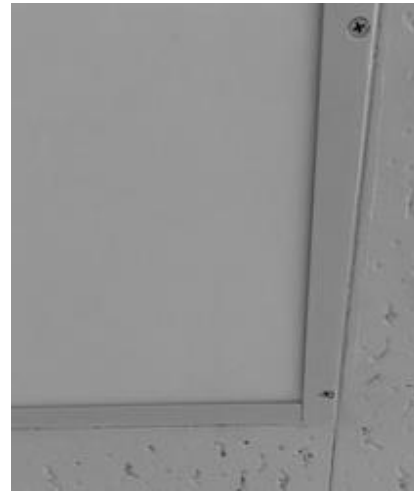
隙間をコーキング剤で埋めた状態
